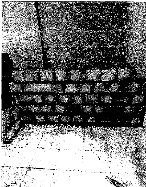
Foto 02: alvenaria de bloco.
